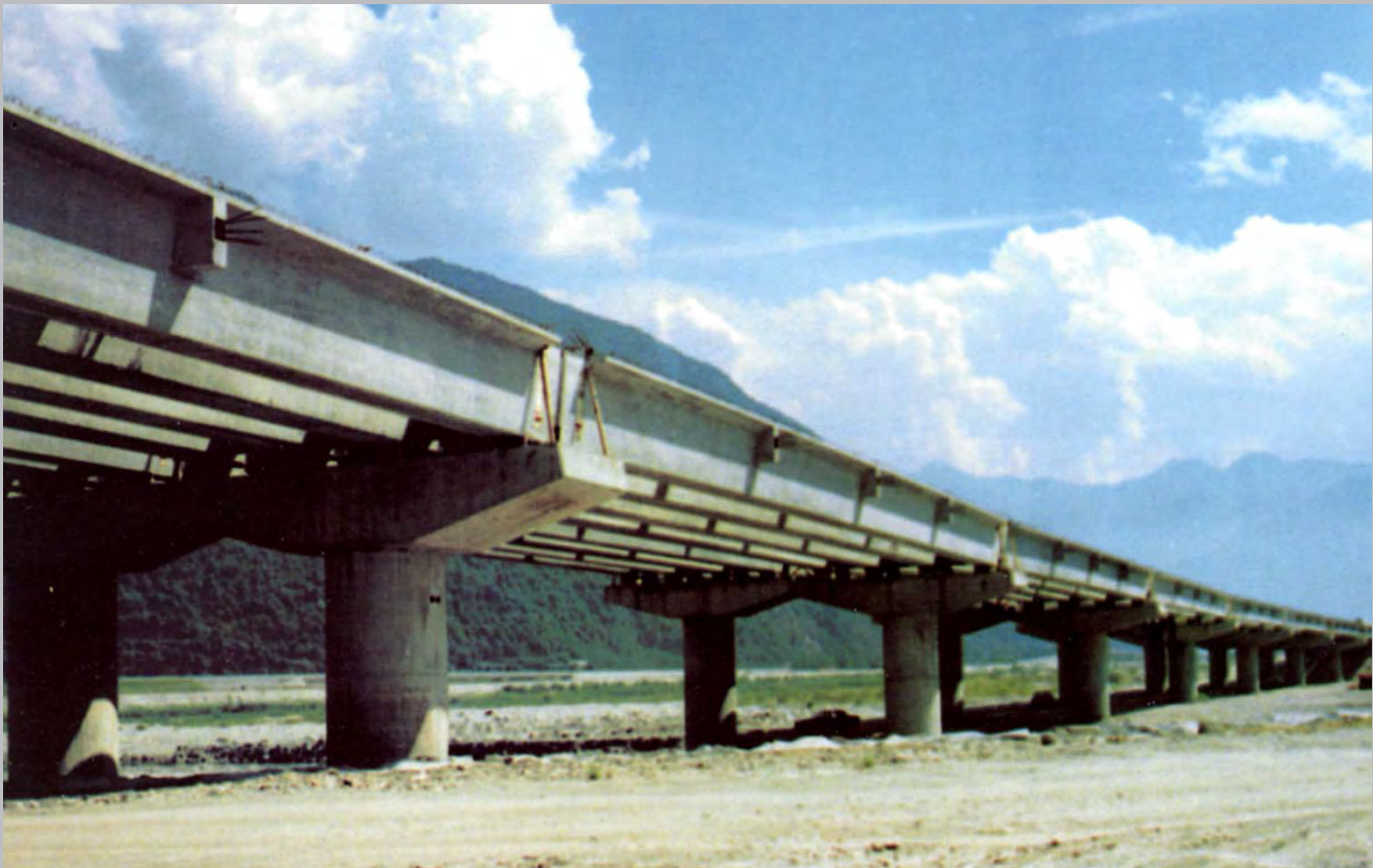
A.N.A.S. Torino - Superstrada del Sempione tratto Ornavasso/Domodossola
